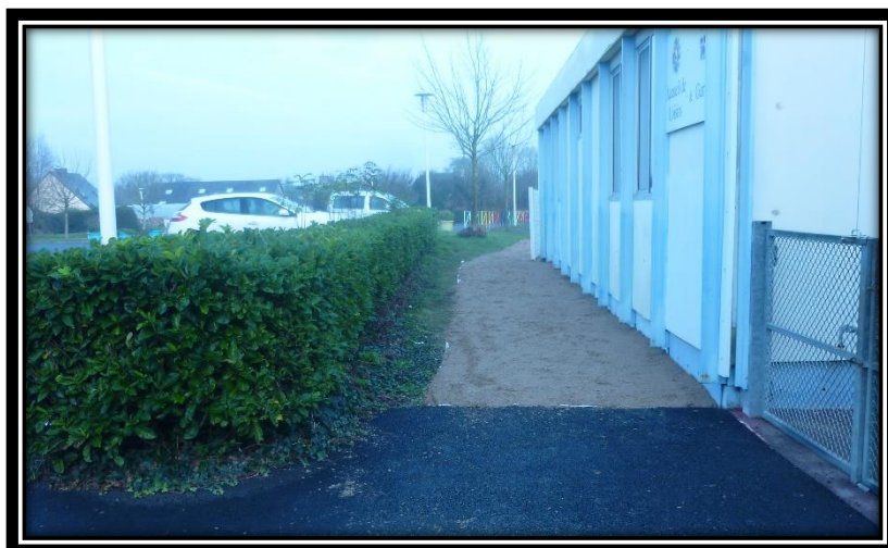
Création d'un chemin pour sécuriser le déplacement des enfants entre la cantine et la cour de l'école.
